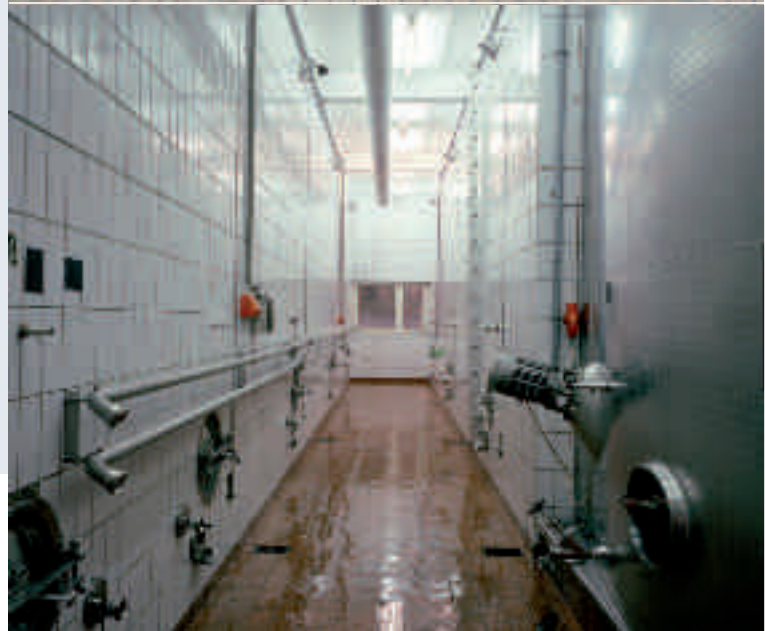
Winzereigenossenschaft, Durbach/Deutschland Winemaker's cooperative, Durbach/Germany Coopérative de viticulteurs, Durbach/Allemagne
