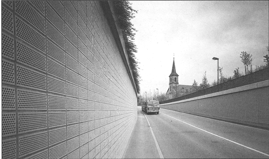
Abb. 5: Straßenunterführung in Dillingen/Saar
