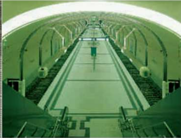
Blindenleitstreifen im S-Bahnhof, Offenbach/Deutschland Conducting strips for blind in suburban railway, Offenbach/Germany Bandes d'orientation pour les mal-voyants dans le R.E.R., Offenbach/Allemagne
