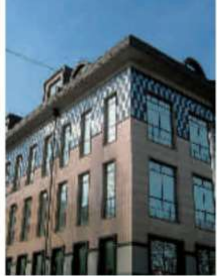
Institutsgebäude, Zagreb/Kroatien Sciencebuilding, Zagreb/Croatia Institut de la recherche scientifique, Zagreb/Croatie
